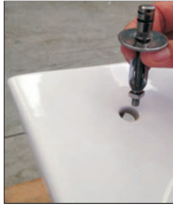
02 Inserire fissaggio nel foro del WC. Insert the screw in the appropriate hole.
